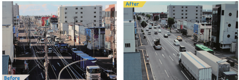
写真1 無電柱化による通りの変化（ビフォー・アフター） 〈苫小牧市栄町・国道36号〉
