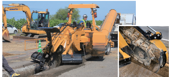
写真3 「トレンチャー」を使った掘削作業の様子
