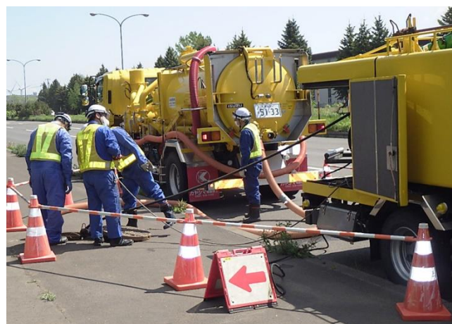
写真：下水道管内高圧洗浄
