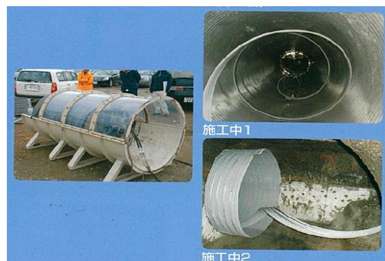
写真：SPR 工法
