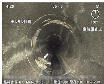
写真：カメラによる管内状況調査
