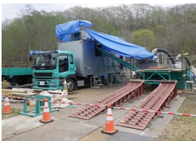
写真：汚泥固化工法 SSD 工法
