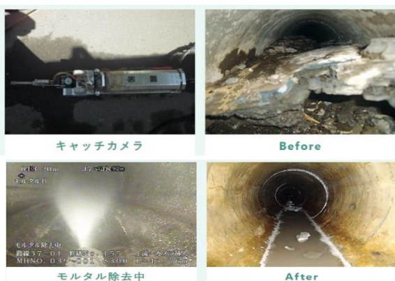
写真：管渠内異物除去作業
