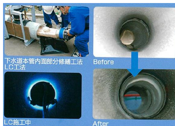
写真：非開削管内部補修(LC 工法)
