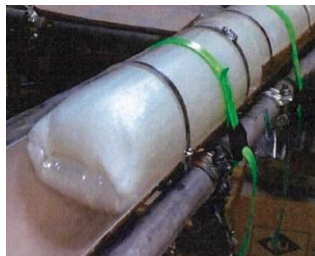
写真：補修材の反転状況
