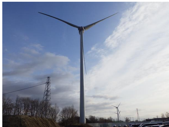
※建設中の風車外観
